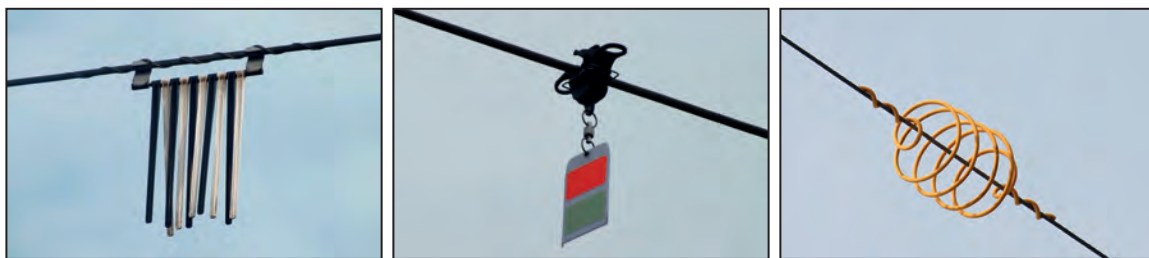
Zviditeľňovacie prvky na vedeniach – tzv. odkolňovače letu (FireFly, špirála a RIBE lamely)
