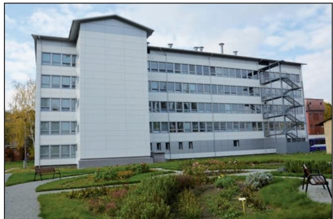
urobiť úpravy na vykurovacom zariadení, odstrániť tepelné mosty, dobudovať regulačnú techniku a hydraulicky využiť vykurovací systém. Samotné zateplenie budovy má zásadné priaživné účinky na zníženie potreby energie na vykurovanie, ale aj odstránenie povrchovej kondenzácie vodnej parы s následnou tvorbou plesní. Odstráni sa zatekanie cez obvodový a strešný plášť, či okná. Nosné konštrukcie už nebudú namáhané vplyvom teplotných rozdielov. Architektonické riešenie zateplenia navrhlo
